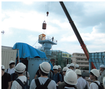
掘削した土砂を排出
