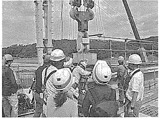
桁架設を見学
