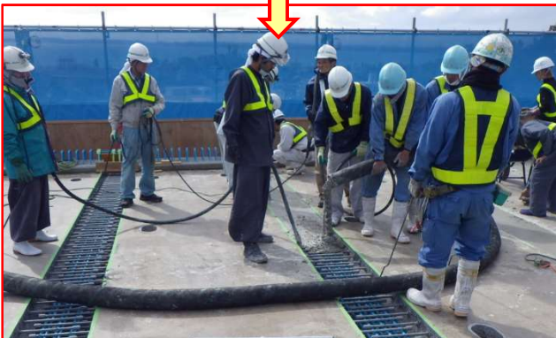
間詰部コンクリート打設
