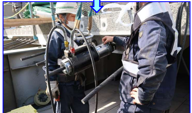
橋軸方向ポステン緊張
