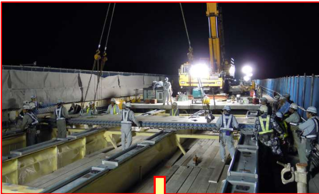
PCa 床版架設
