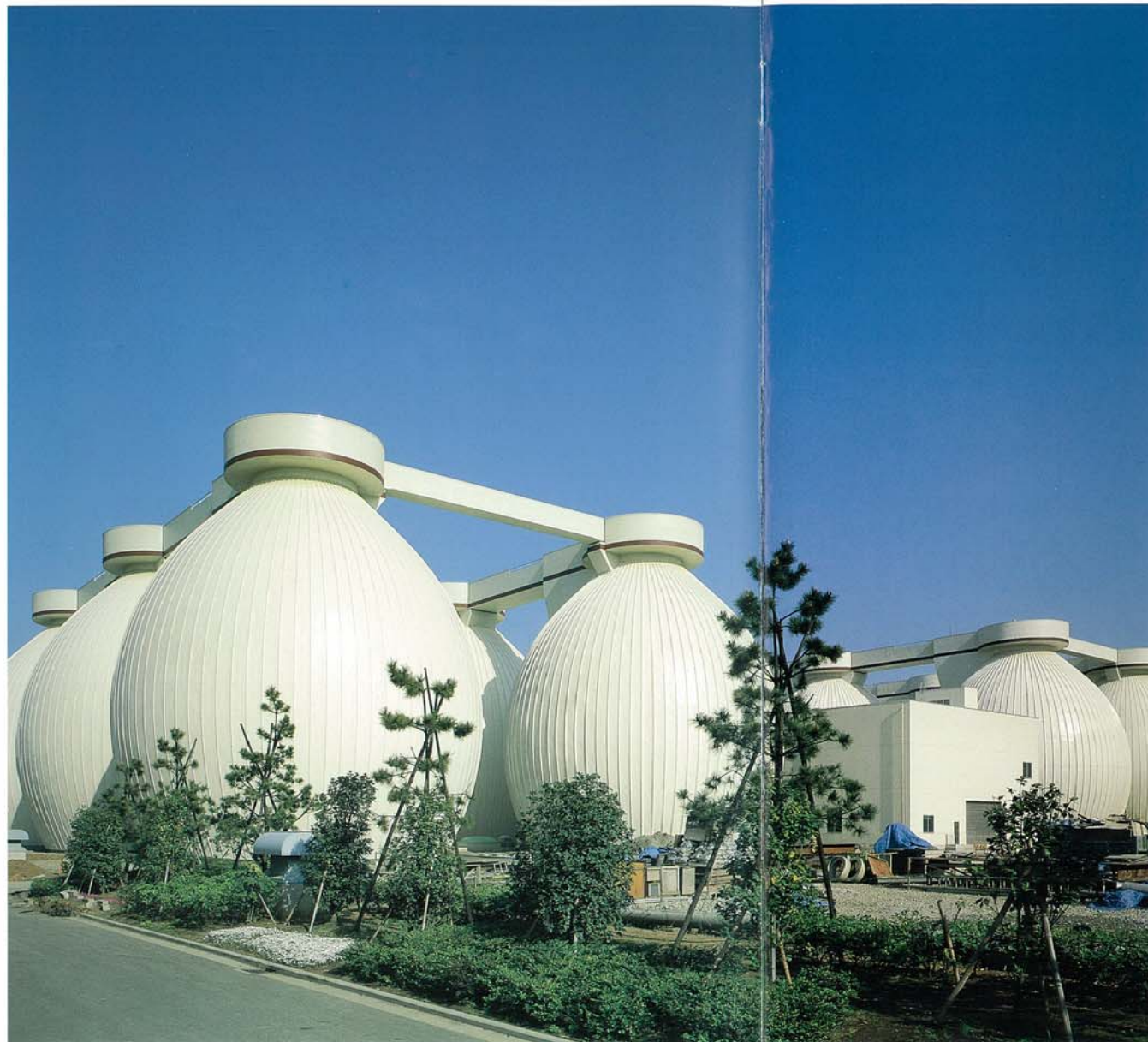
横浜市北部第二下水処理場 一期工事 6,800m 3 6基 二期工事 6,800m 3 6基
