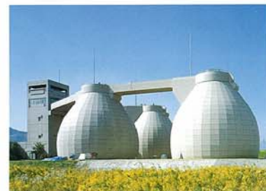
京都府洛南浄化センター 4,000m 3 1基
