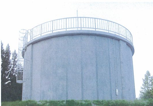
安里配水池 (沖縄県) 二重円筒式 容量:13,300t 内径:34.6m 外径:49.7m 有効水深:7.1m
