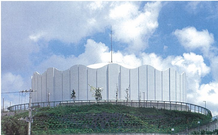
安里配水池 (沖縄県) 二重円筒式 容量:13,300t 内径:34.6m 外径:49.7m 有効水深:7.1m
