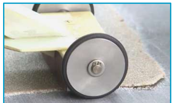
被膜の上から誘導加熱ヘッドで鋼板を加熱
