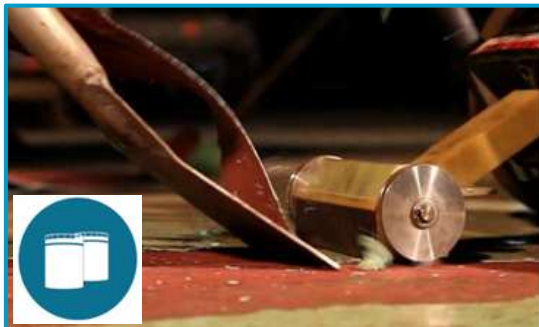
タンク：ガラスフレークライニング
