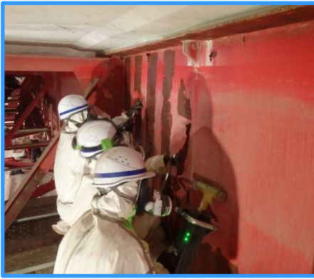
施工事例：鋼桁
