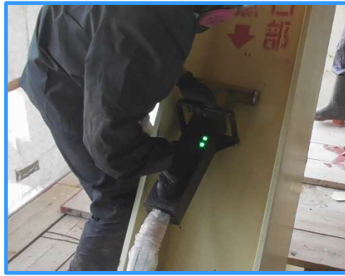
施工事例：トラス
