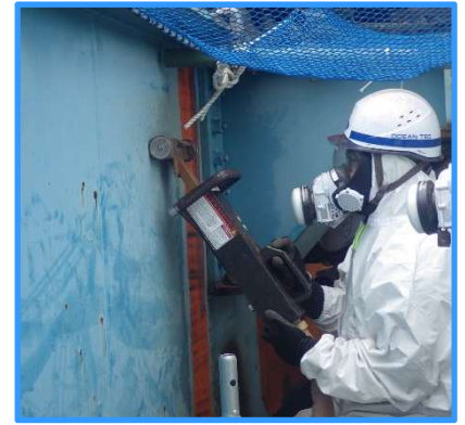
施工事例：鋼支柱
