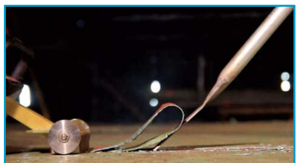
タンク内のガラスフレークライニング除去の状況
