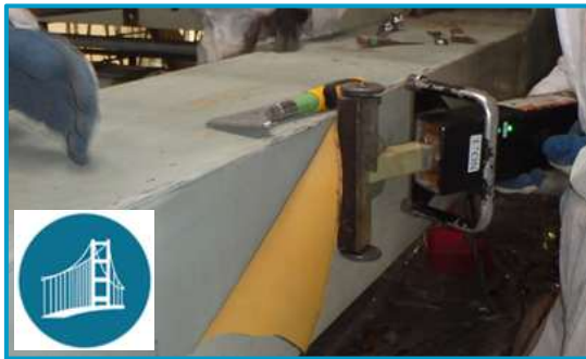
橋桁：防錆コーティング
