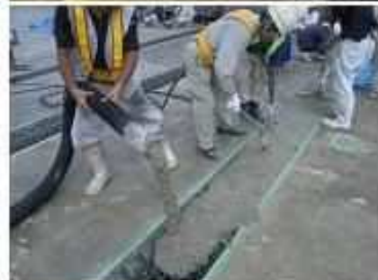
コンクリート打設(接合部)
