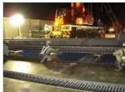
S-LJスラブ架設
