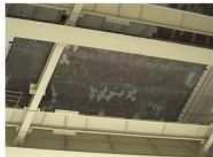
施工前(床版下面)
