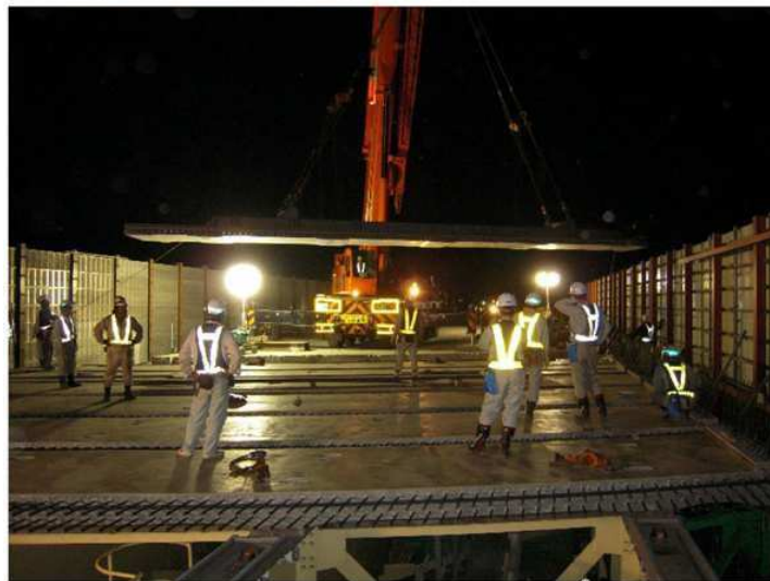
SLJスラブの架設状況
