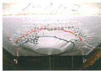
●押抜き試験(破壊時)
