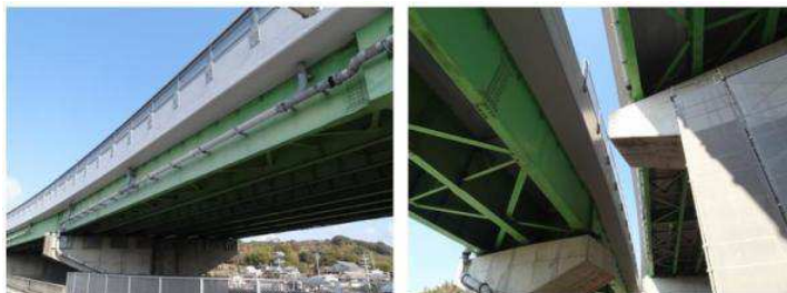
壁高欄および床版下面への適用例
