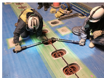
3 H型金物挿入、ボルト締付け
