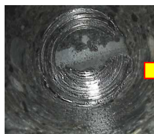
開削前（孔内処理後）
