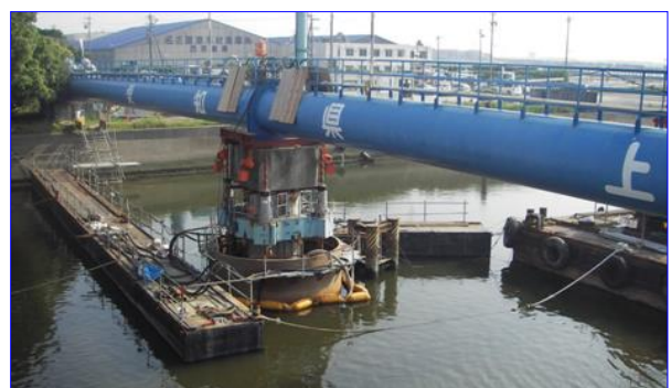
— 水管橋耐震補強の施工状況 —
