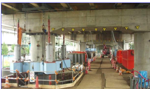
— 道路橋耐震補強の施工状況 —
