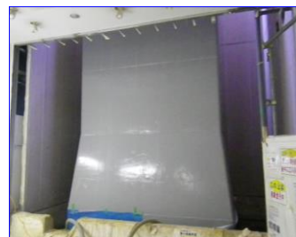
【狭隘な作業空間での施工事例】 橋脚表面と壁の間隔 80cm 程度
