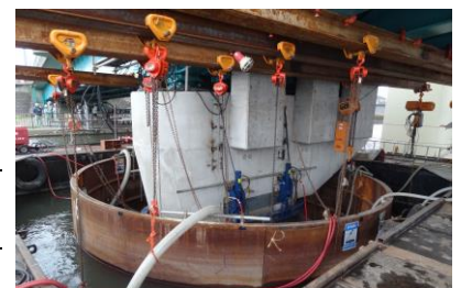
【簡易仮締切による施工事例】
