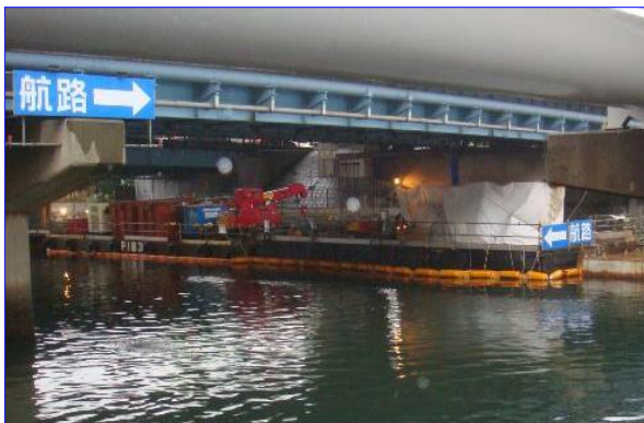
【狭隘な桁下空間での施工事例】
