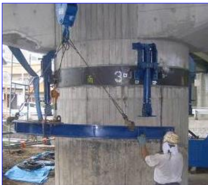
分割・小型化された専用の圧入装置, WJ削孔装置
