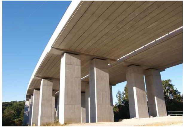
■ 億首川橋(SCBRI法)
