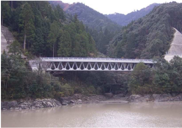
■ 鎌の谷橋(プレキャストセグメントトラス橋)
