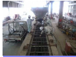
コンクリート打設
