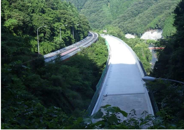
■ 中国自動車道 市川橋(SLJスラブ)
