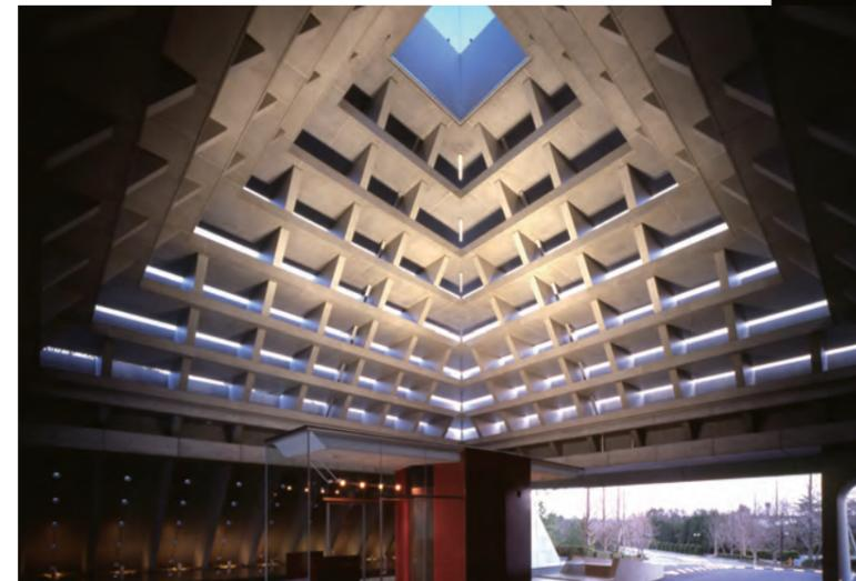
建物の構造は地上から 4mの高さまでは現場打ちPC造、その上部、約 10mの高さをPCa組立造で計画されており、実際のピラミッドの約 1/10の規模で計画されました。また工場で作られた高品質なプレキャスト部材は、意匠的に見せる構造部材として内部空間に積極的に取り入れられています。
