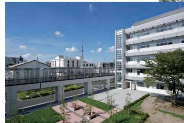
特に全長約 160m に渡る連絡デッキ棟は、施工時における既存建物内部からの研究者の動線を極力妨げない施工が求められましたが、プレキャストPC造により、現場作業を極力減らし工事期間を短縮することで要求を実現するとともに、低騒音、廃棄物の削減といった環境負荷の低減効果をもたらしました。
