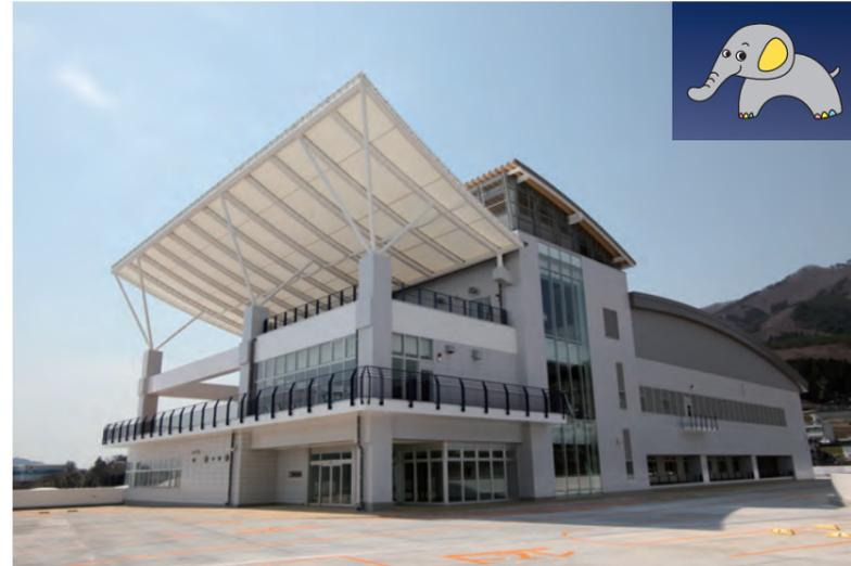
構造躯体は塩害対策、長寿命化、工期短縮が考慮され、柱、梁、床版をプレキャスト部材としたラーメン架構とし、プレストレスによる圧着接合にて施工されました。施工中の2011年に東日本大震災が発生、現場も津波により大きな被害を受けましたが、2014年に無事竣工を迎えました。
